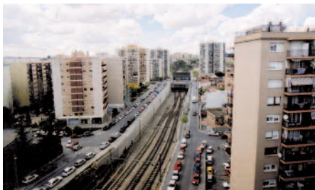
La vía del tren antes de ser cubierta
