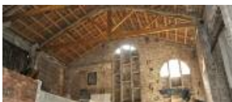
Imatge del sostre des de l'interior
