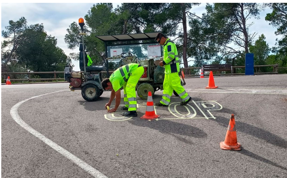
Els treballs de pintura s'han dut a terme al novembre.
