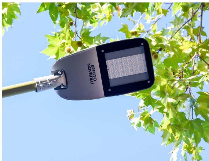
La nova lluminària disposa de tecnologia LED de 80 W.
