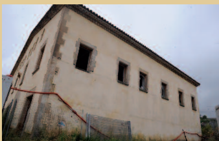
La Masia Can Serra abans de la rehabilitació
