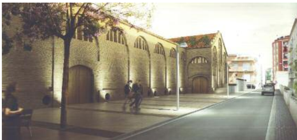
Aquest és l'aspecte que tindrà l'exterior del Celler un cop finalitzin les obres
