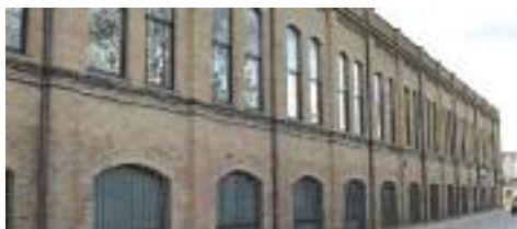
Façana d'obra vista de l'edifici nord
