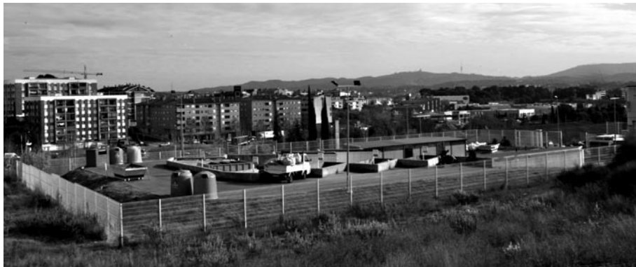
Deixalleria de Cova Solera
